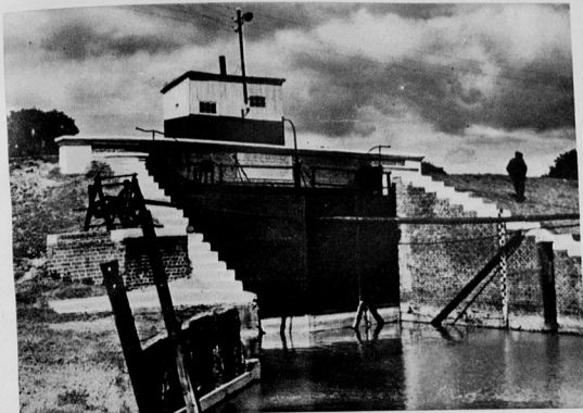
Eine „Siele“, selbsttätig arbeitende Schleusen-Anlage zur Regulierung der Ebbe- und Flutströmungen
