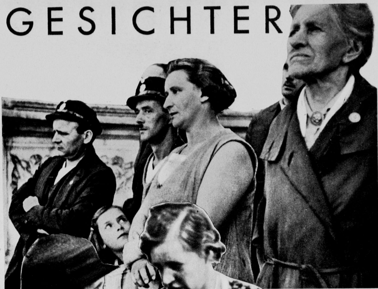
Am Unglücksschacht des Baues der Nord- Süd-S-Bahn in Berlin
