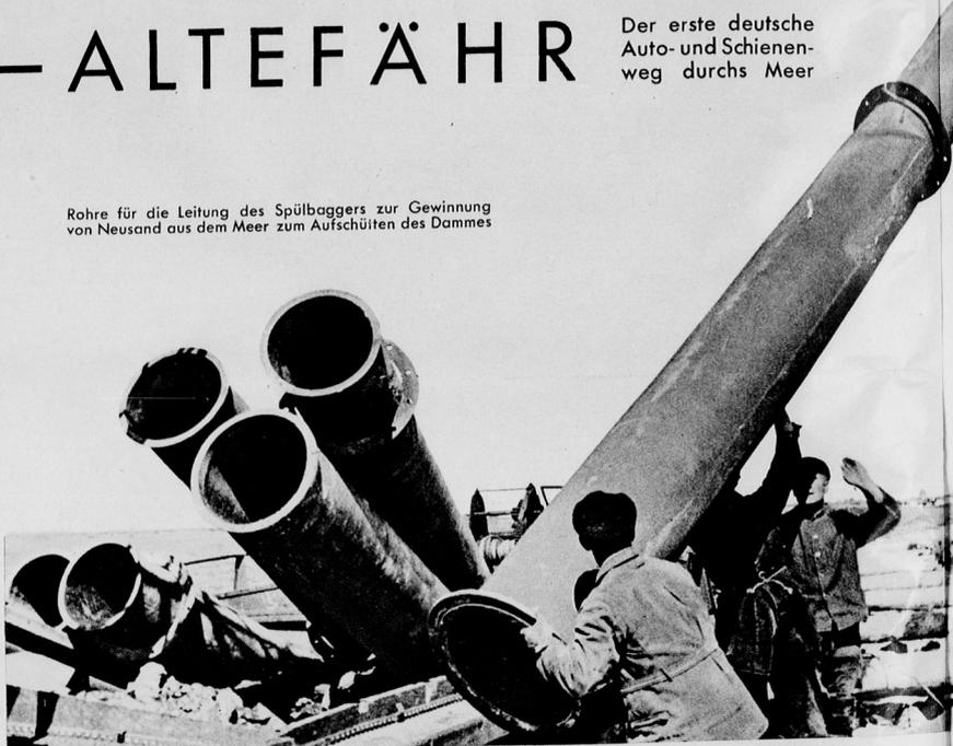
Rohre für die Leitung des Spülbaggers zur Gewinnung von Neusand aus dem Meer zum Aufschütten des Damms
