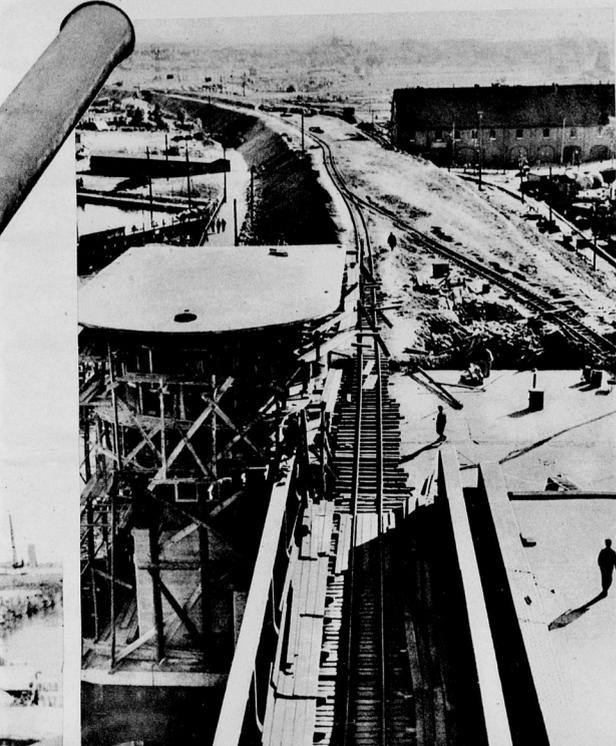
Der Damm ist ziemlich bis zur vollen Höhe aufgeschüttet, dann wird mit den Planierungsarbeiten begonnen
