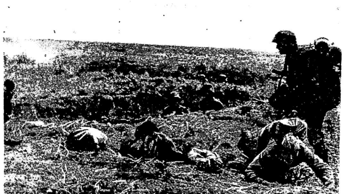
Einbruch in die feindliche Stellung
