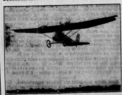
Das sie greiche Flugzeug Die Maschine des Siegers Forster, das Messerschmitt-Daimler-Sportflugzeug „L. 21“, das zwei im Flug liegende, luftgekühlte Motoren besitzt...
