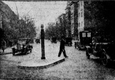
Blinkfeuer auf der Corneliusbrücke Ein neuer Leuchtturm, dessen Lampe die Fahrzeuge vor einer gefährlichen Ecke warnt Sonnens
