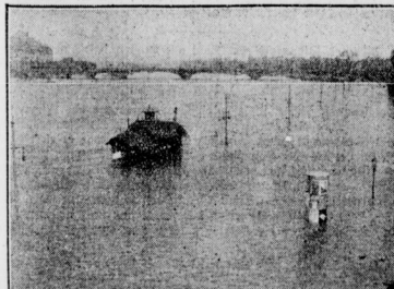
Dresden unter Wasser Die über ihre Ufer getretene Elbe
