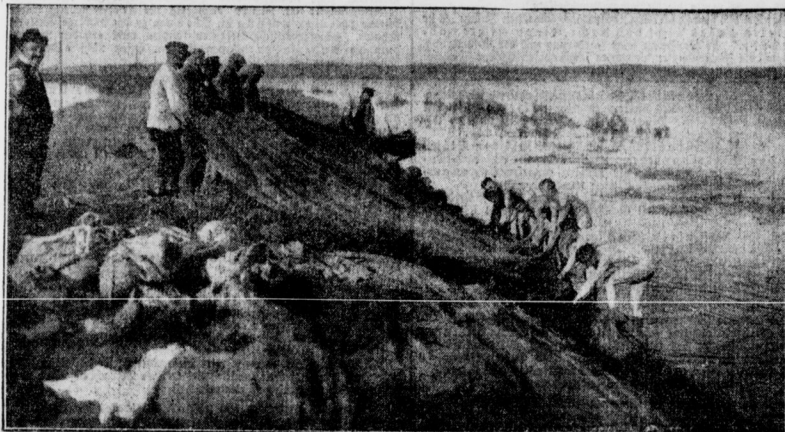
Der Kampf gegen die Fluten Der Damm des Grossschiffahrtsweges Berlin-Stettin wird bei Schwedt an der Oder abgedichtet
