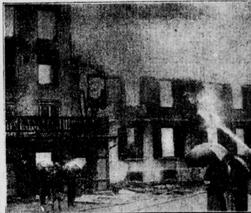
Die Katastrophe in Mürren (Schweiz) Die Feuerwehr löscht den Brand des Hotels „Des Alpes“
