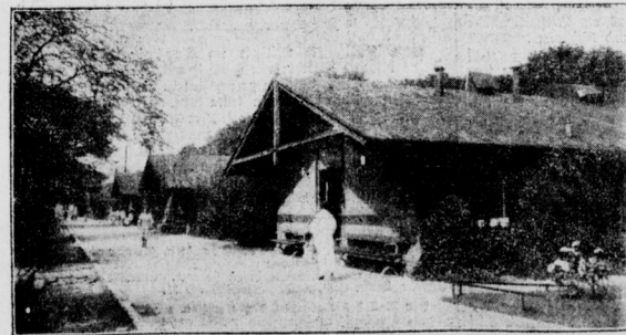
Das Moabiter Krankenhaus wird umgebaut Die Choleraabzacken aus dem Jahre 1870 verschwinden
