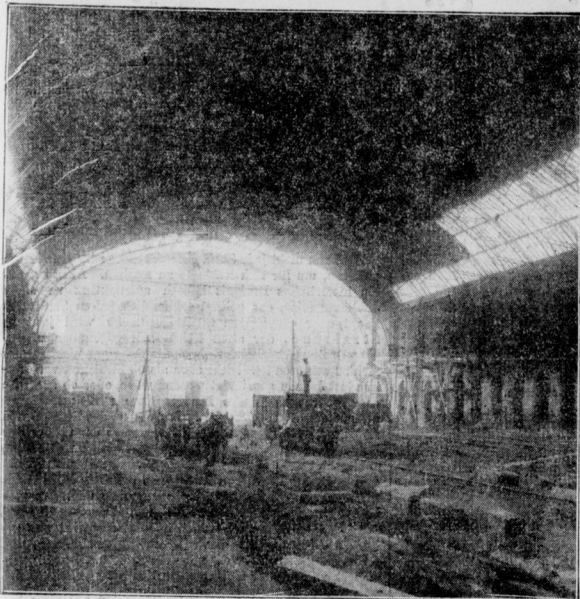
Der frühere Ostbahnhof wird Variété — Blick in die im Umbau befindliche Halle Eryslons
