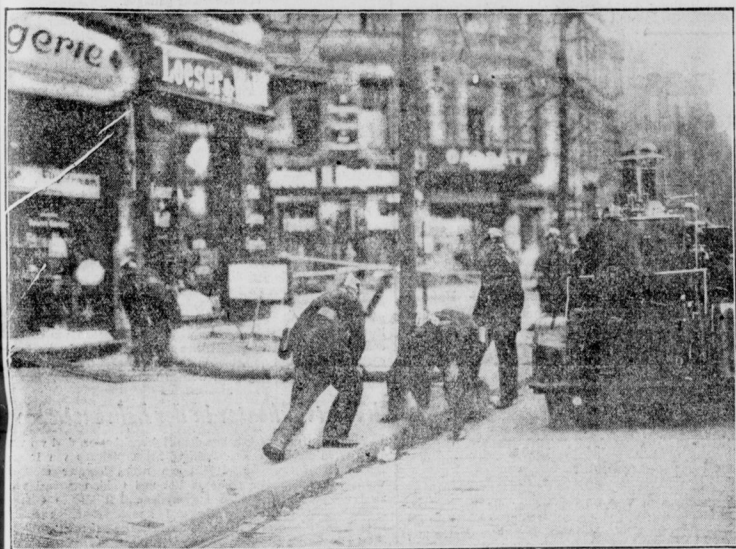
Der grosse Wasserrohrbruch in der Elsässer Strasse
