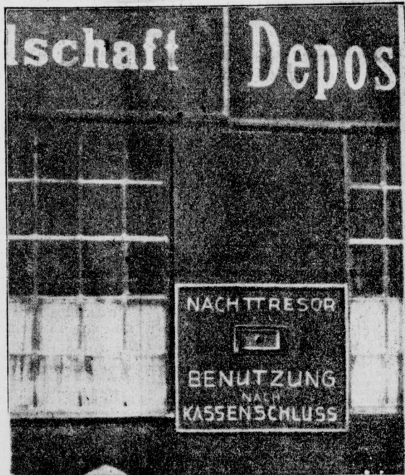
Du kannst dein Geld auch los werden, wenn die Banken schon geschlossen sind — In der Fasanenstrasse gibt es jetzt einen Nacht Banktresor,
