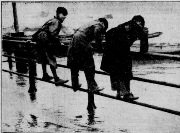
London durch Ueberschwemmung bedroht Das überschwemmte Themse-Ufer bei Putney in der Gegend der englischen Hauptstadt
