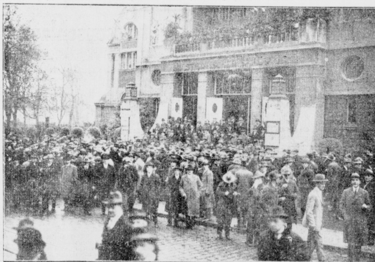
250 000 Metallarbeiter brotlos Im Essener Saalbau protestierten die Ausgesperrten gegen die Willkür der Eisenbarone
