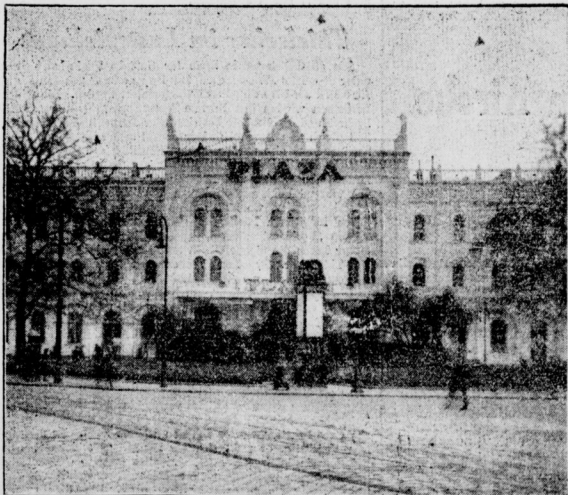
Der Umbau des Ostbahnhofes in das Theater „Plaza“ ist vollendet
