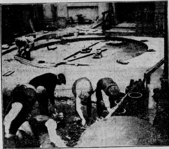
In schmalen Gassen Londons werden Drehscheiben eingebaut, die Automobilen das Wenden ermöglichen
