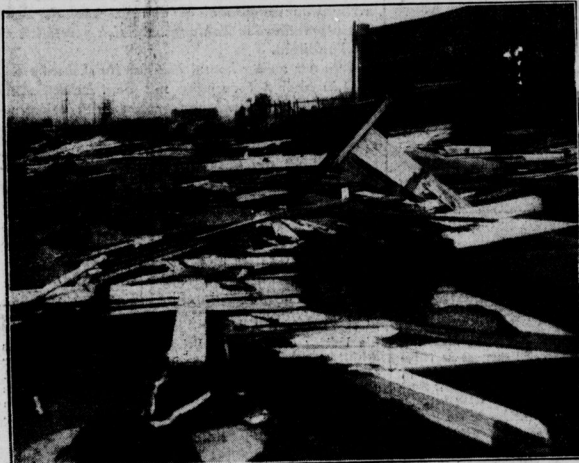
Das Dach einer Halle im Transformatoren-Werk Lichtenberg wurde abgehoben und stürzte auf eine danebenliegende Werkstatt
