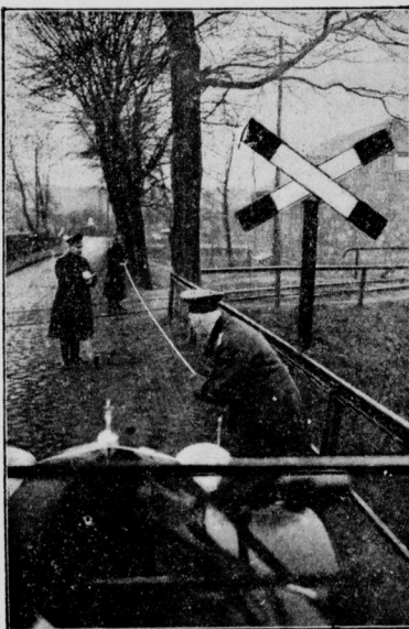
Der Abstand zwischen den Verkehrszeichen wird abgemessen
