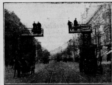
Die Strassenbahn kontrolliert ihre Oberleitungen
