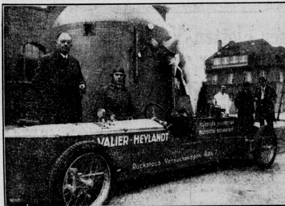
Max Valiers neuer Wagen tankt flüssigen Brenn- und Sauerstoff
