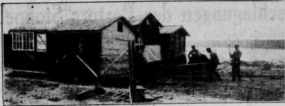
Die Lauben werden abgebrochen —
