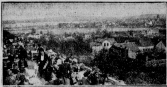
Mal der Terrassen von Warden
