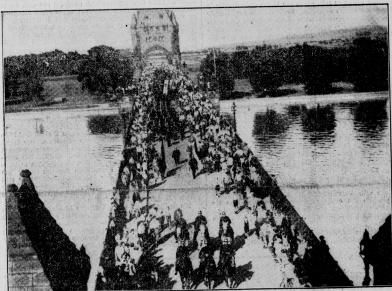
Die Schutzpolizei zieht über die Wormser Brücke
