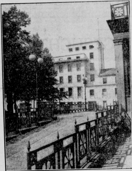
Das neue Gebäude ist jetzt fertig- gestellt worden
