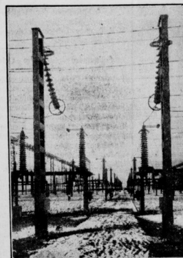
Rheinisch-westfälisches Elektrizitätswerk Höchstvoltsammelschienen der Hauptstättliche Brauerei
