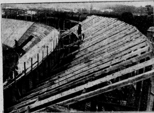
Die Wiederherstellung der abgebrannten Radrennbahn ist fast beendet
