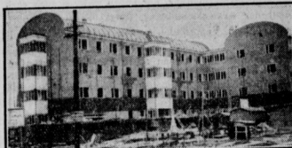
Die ersten Häuser mit neuartigen Tonnen-dächern
