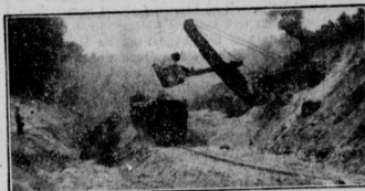
Bau der neuen Autostrasse im Grunewald
