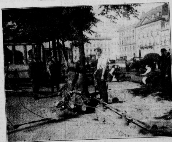
Auf der Strasse Unter den Linden wurde heute einer der ältesten Bäume niedergelegt
