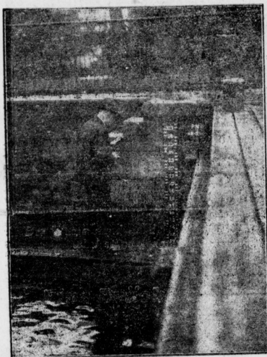
Der Wasserstand an der Mühlenschleuse wird ständig kontrolliert
