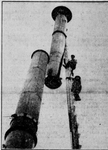
Schnellmontage einer Fabrik-Esse
