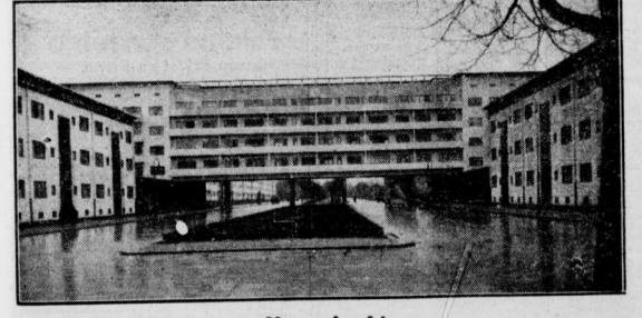
Unten durch! In der neuen Siedlung in Reinickendorf-Ost, „Die weiße Stadt“, ist ein Haus über die Straße gebaut worden, so dass sich der Verkehr ungehindert abwickeln kann
