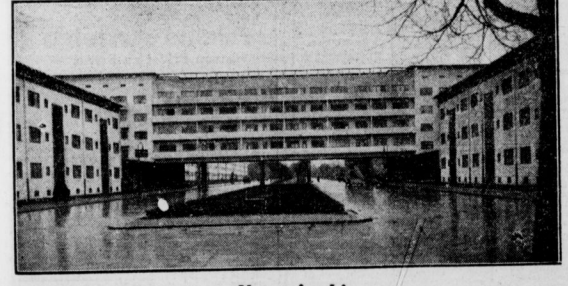
Unten durch! In der neuen Siedlung in Reinickendorf-Ost, „Die weiße Stadt“, ist ein Haus über die Straße gebaut worden, so dass sich der Verkehr ungehindert abwickeln kann
