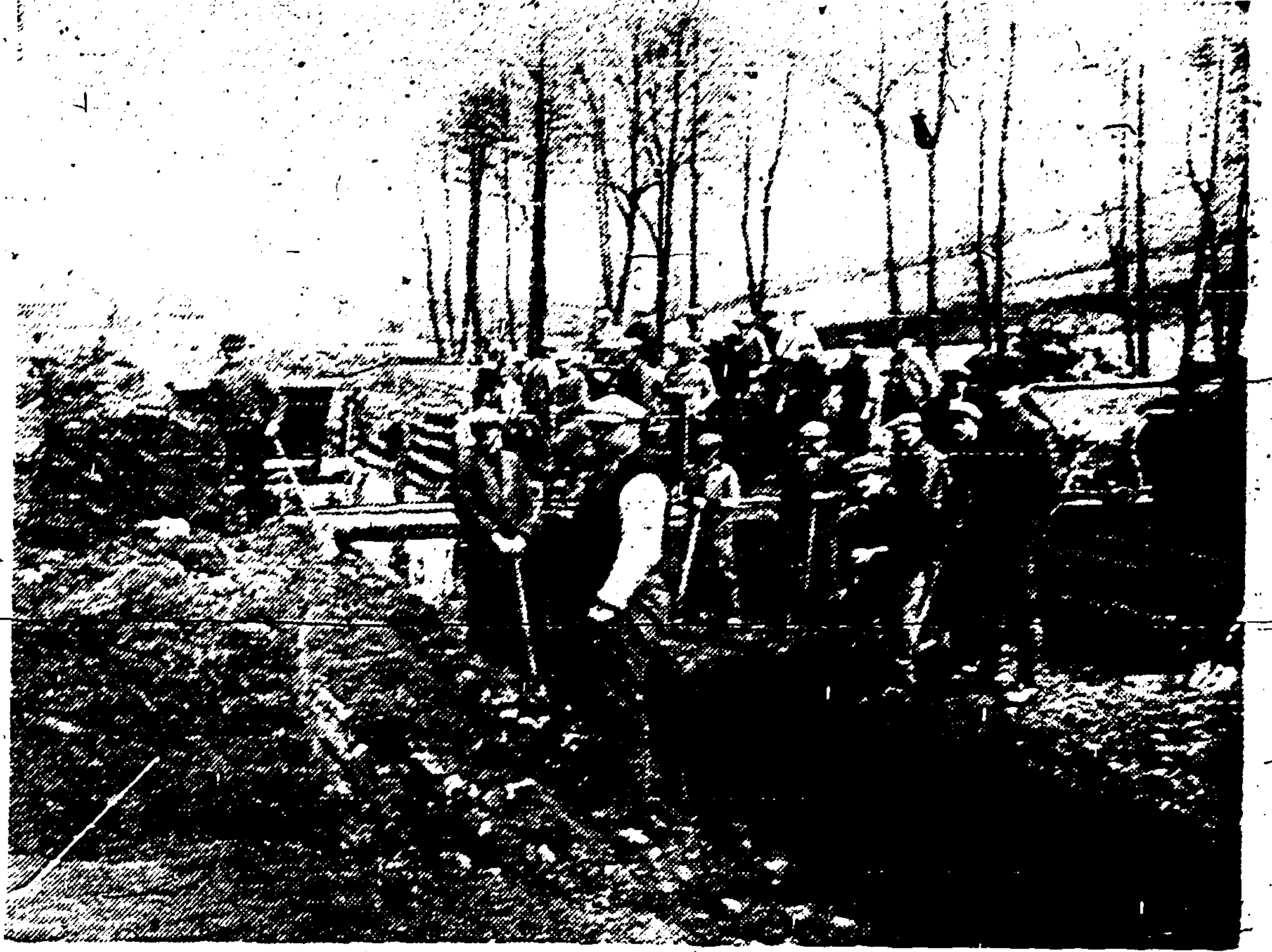
Der Adolf Hitler-Kanalbau gibt Tausenden Brot Unser Bild zeigt den Beginn der Arbeiten
