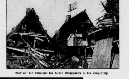
Sicht auf die Trümmer der beiden Wohnhäuser in der Langestraße
