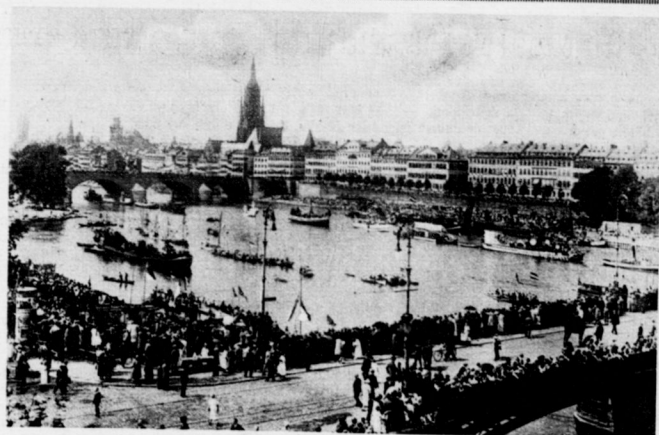
Feierliche Einweihung der neuen „Alten Mainbrücke“ in Frankfurt Schiffsfestzug anlässlich der Brückenweihe
