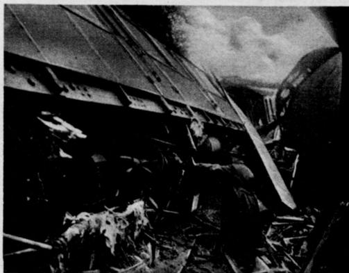
Die Katastrophe des Rhein-Deutscher Schnellzuges bei Kallbeche (Dahnener) zwischen den Trümmern der ineinandergefahrenen Wagen. — Oben: Die Entgleisungsbelle mit den unbeschädigt neben den Schienen liegenden Schwellen- und Daishenschrauben. Dieser Fund läßt auf ein Eisenbahnentatent schließen
