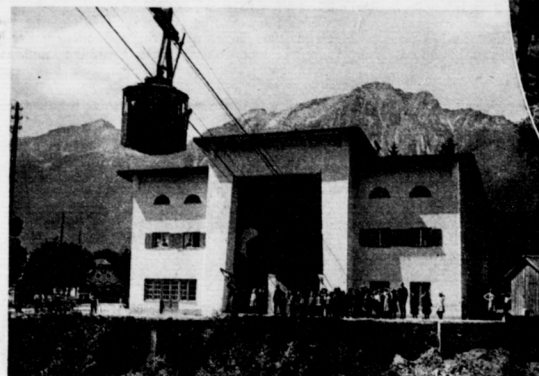
Zur Eröffnung der Seilseilbahn auf den Predigtstuhl bei Bad Reichenhall Die Lastkabinen. Im Hintergrund der Stausen und der Zwiesel (Kretzer & Co.)
